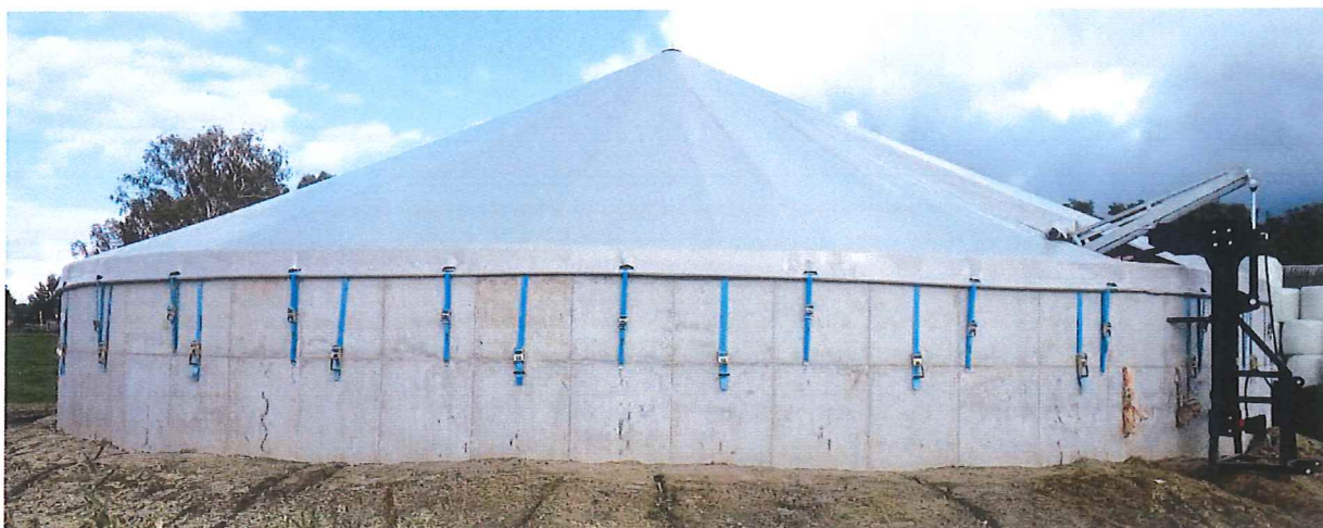
Widok przykładowego zbiornika z zadaszeniem plandekowym, od prawej - otwór włazowy z mieszadłem.
